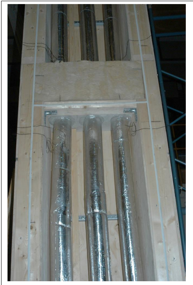
Tappvattenrör med isolering monterade i provschaktet
