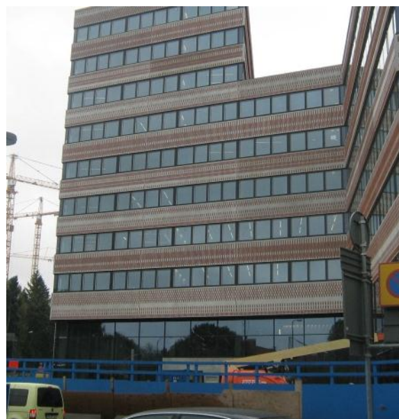
Foto av Folkhälsohuset under byggnad
