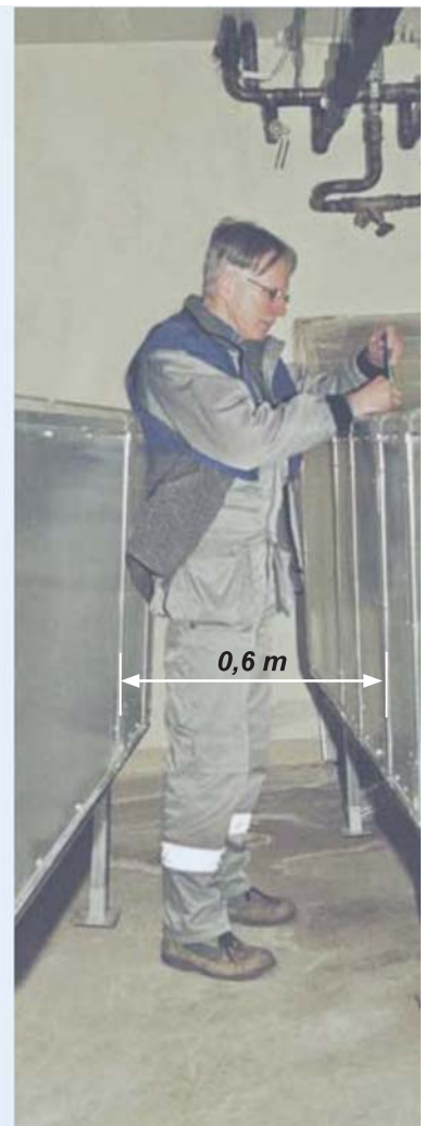
Mellan två apparater krävs en bredd av minst 0,6 m för att en person ska kunna passera. Detta mått anger fritt utrymme. Annan utrustning, till exempel rör, ventiler eller termometrar får inte inkräkta på utrymmet.
