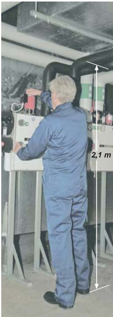
Den fria rumshöjden från golvet till fasta hinder i taket ska vara minst 2,1 m.
