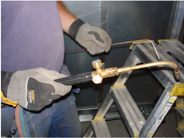
Bild 1. Utrustning för lödning av kopparrör
