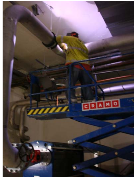
Bild 7. Svetsning från saxlift
