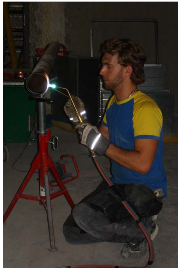
Bild 10. Lödning av kopparrör
